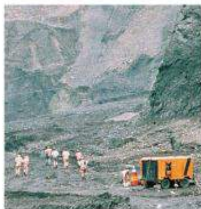
Proceso de exploración e instalación de equipo minero en la zona conocida como la Colosa en Cajamarca, Tolima.
